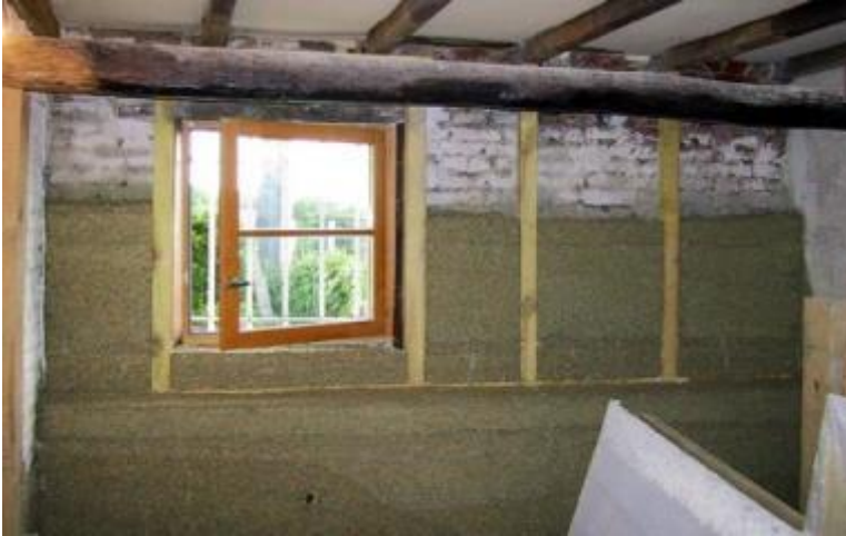
Isolation mur intérieur
